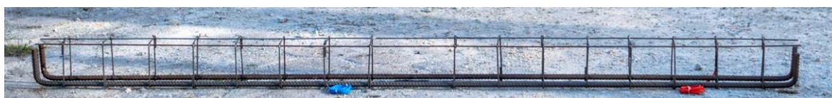
Figura 4.14 – Armadura da Viga VSW1
