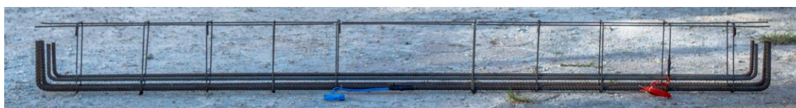
Figura 4.12 – Armadura da Viga VD1
