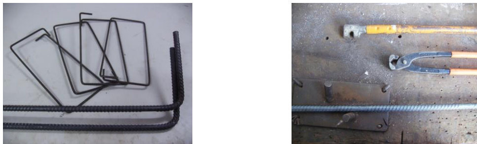
Figura 4.8 – Dobra e corte das armaduras
